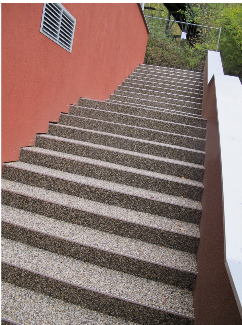
Zrekonstruované venkovní schodiště
